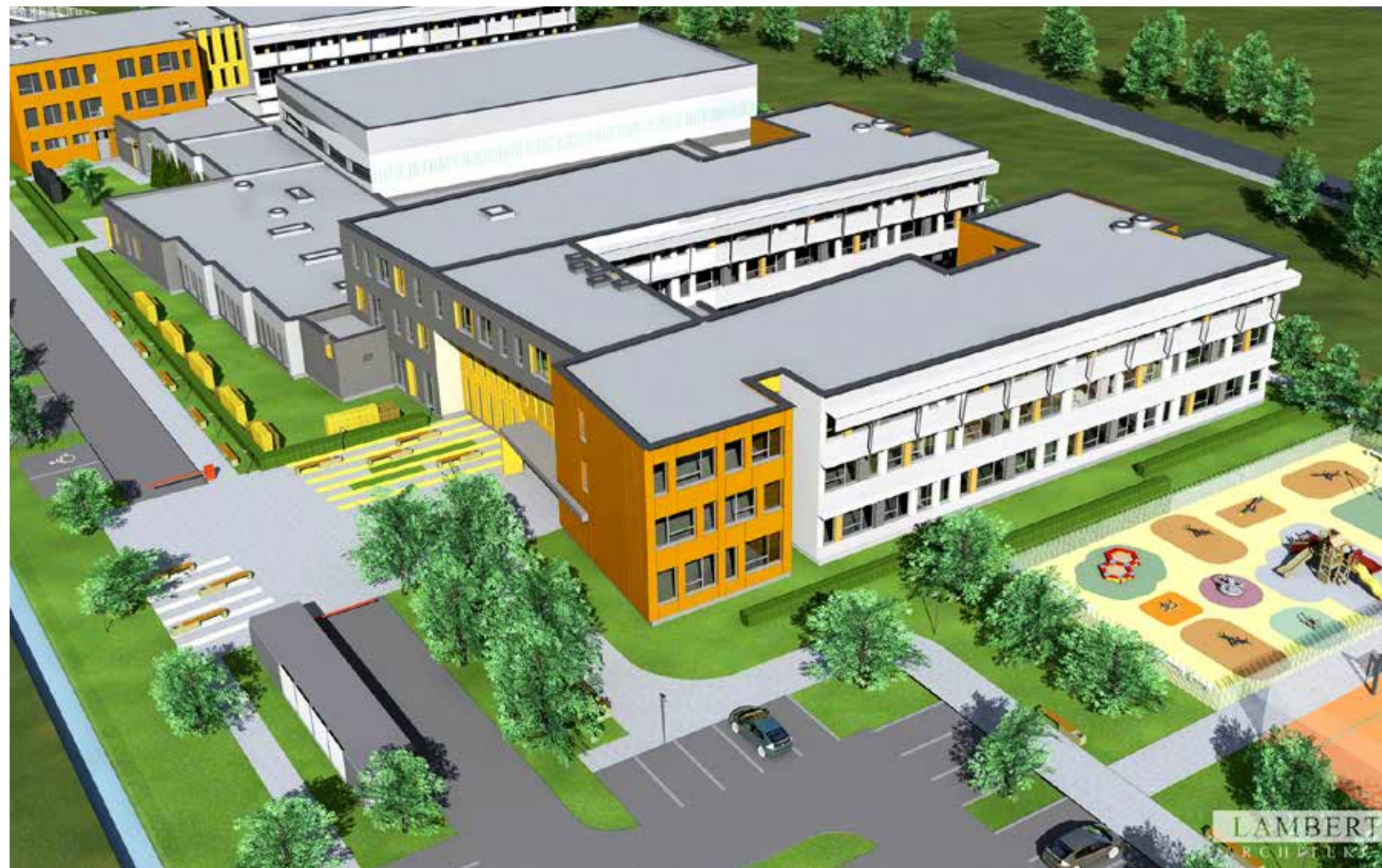
BUDOWA SZKOŁY PODSTAWOWEJ
