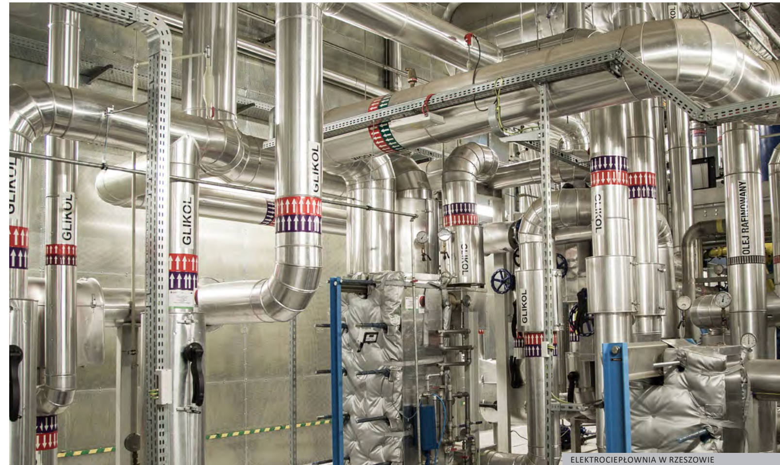
ELEKTROCIEPŁOWNIA W RZESZOWIE
