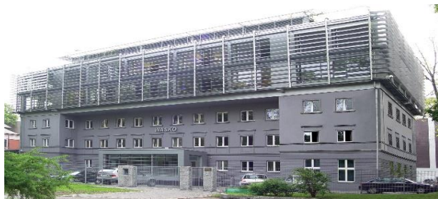
Siedziba WASKO S.A. Warszawa, ul. Czackiego
