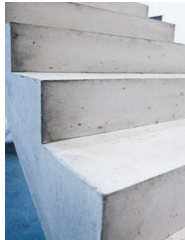
Elementy prefabrykowane – schody
