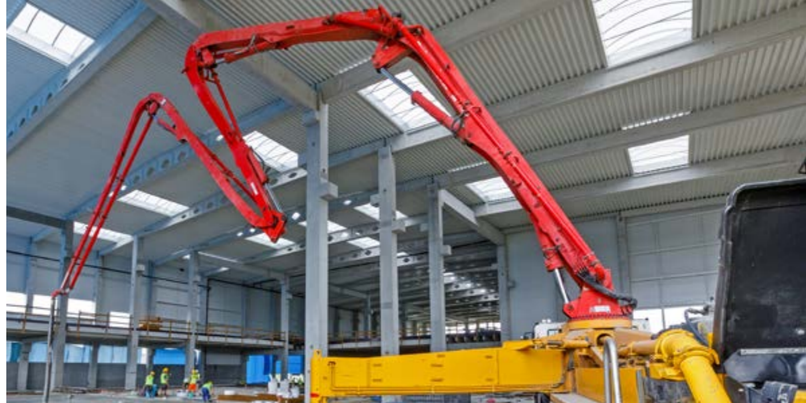
Budowa nowoczesnego zakładu Pekabex w Gdańsku-Kokoszkach
