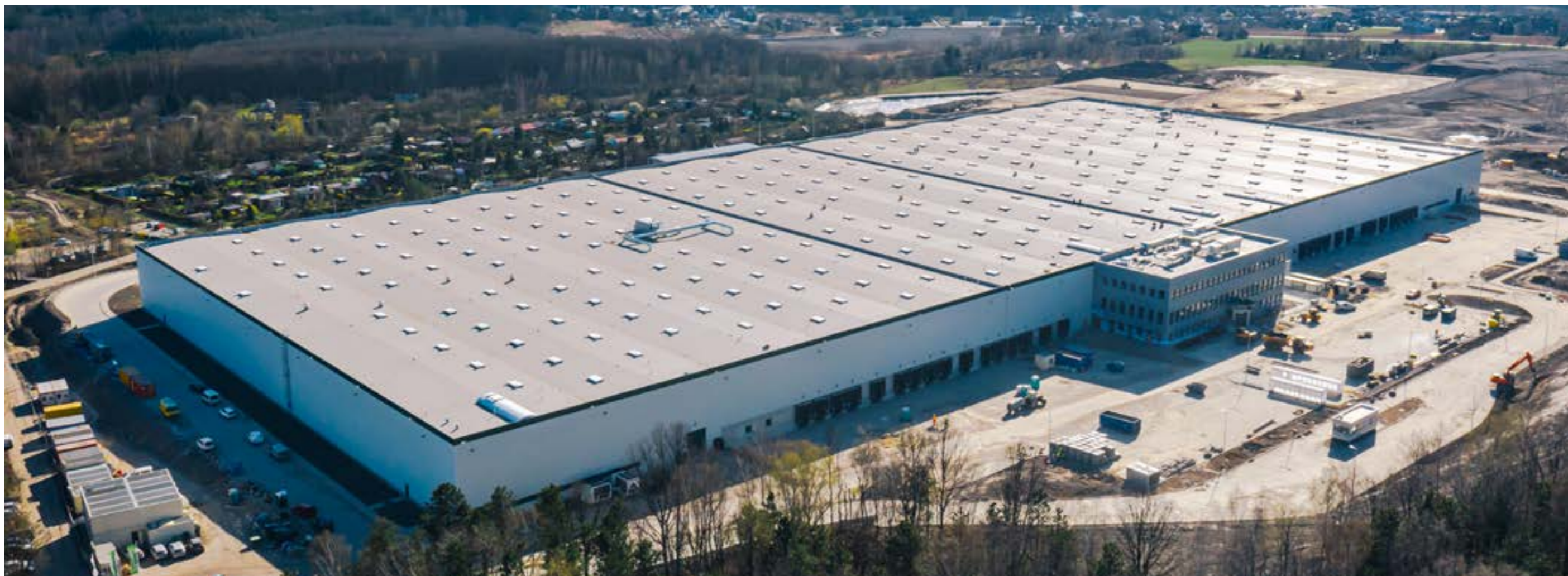
Hala Prologis, Ruda Śląska
