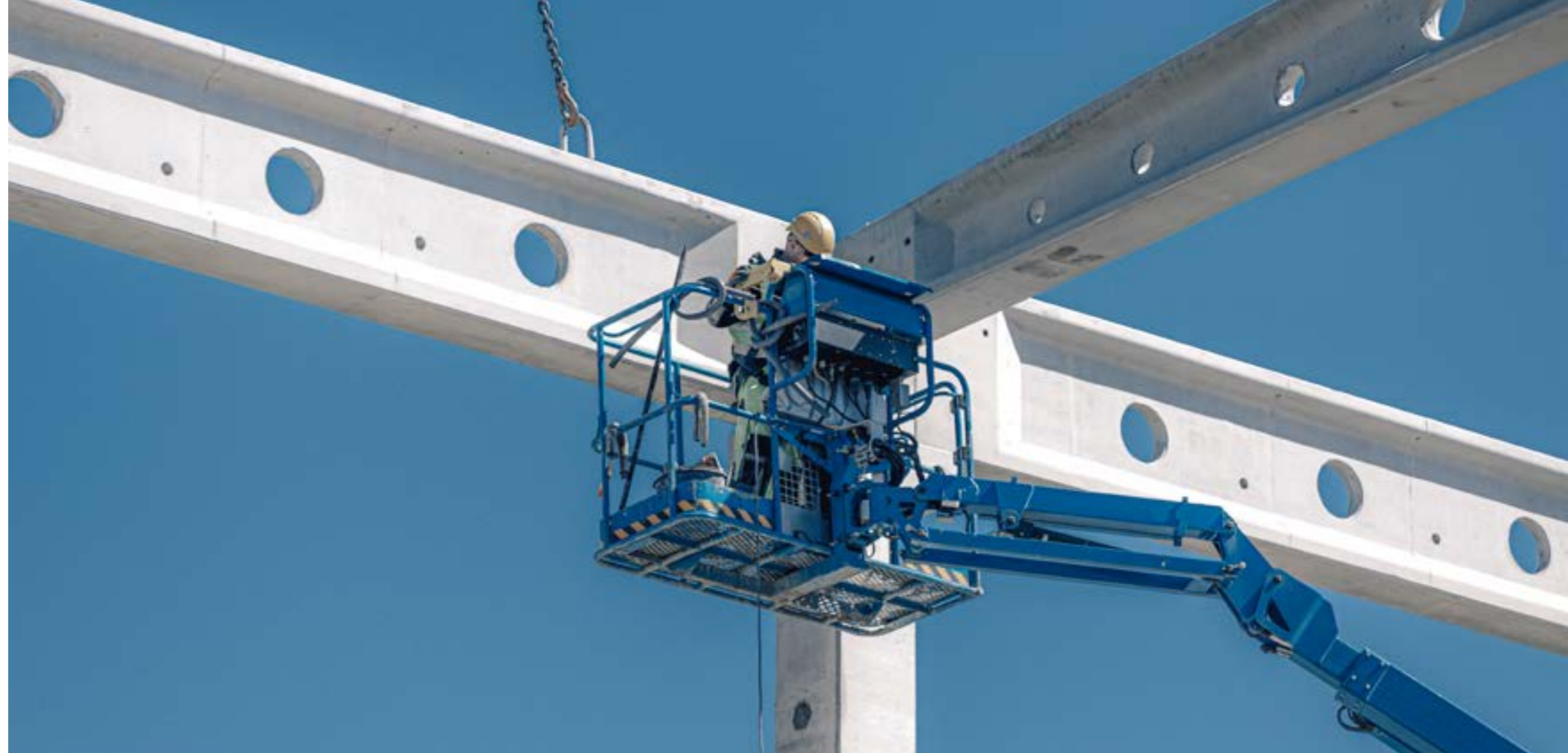
Montaż konstrukcji hali Panattoni, Bielsko-Biała
