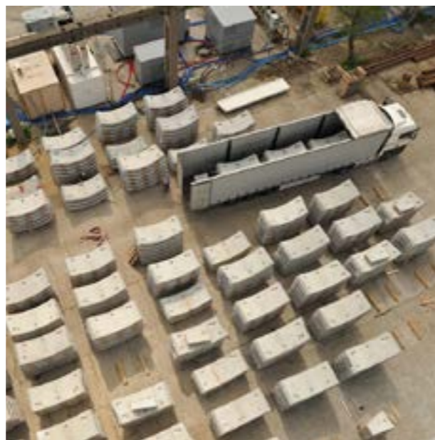
Elementy do budowy tunelu w Łodzi
