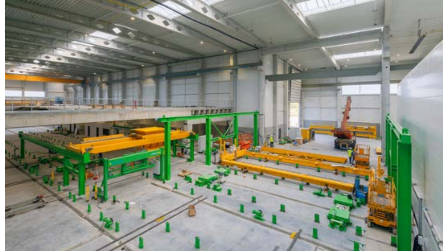
Budowa nowoczesnego zakładu Pekabex w Gdańsku-Kokoszkach
