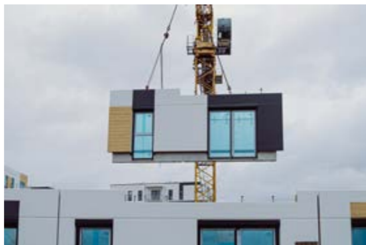
Montaż ścian na Osiedlu JA_SIELSKA, Poznań
