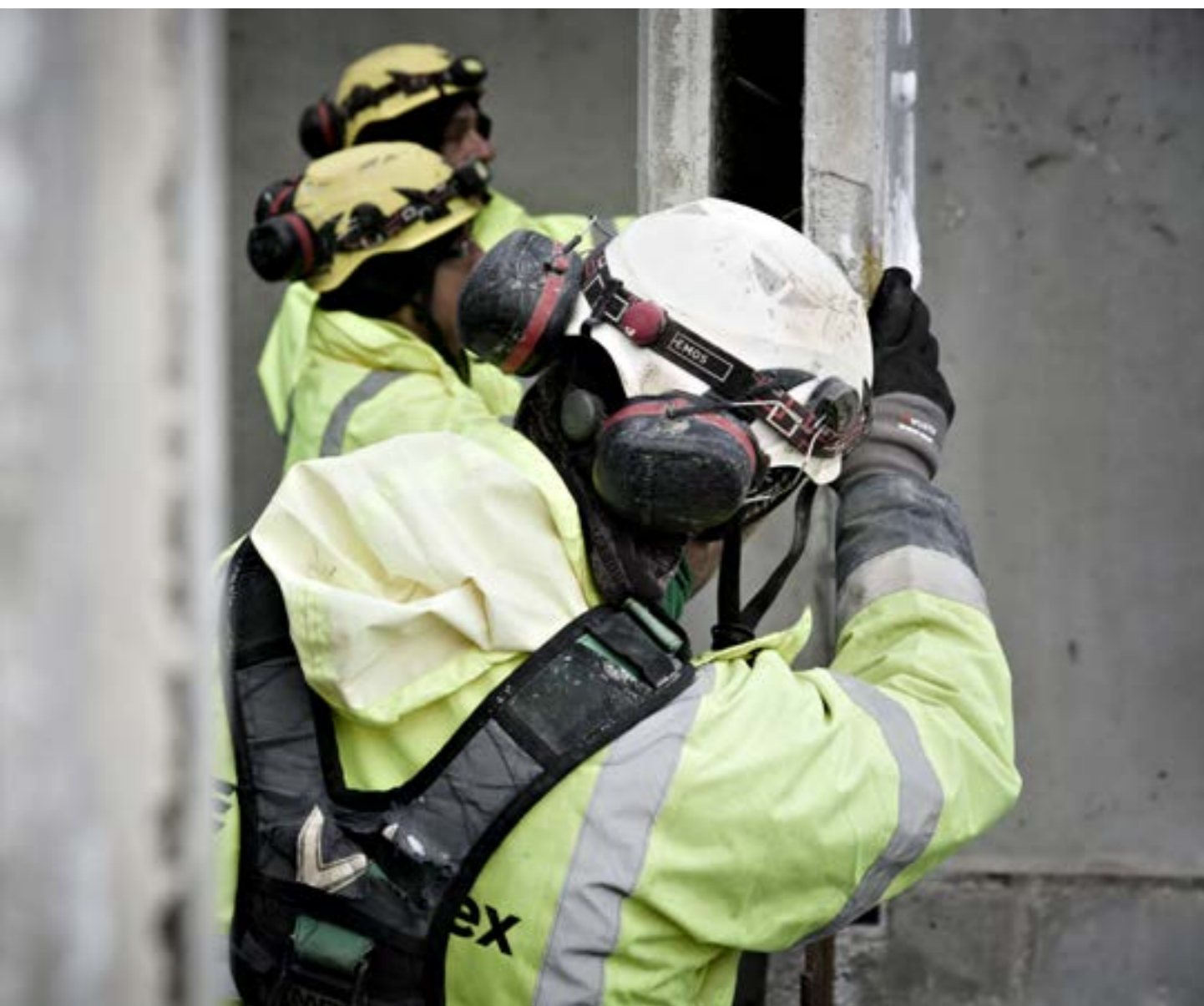
Montaż konstrukcji prefabrykowanej, Gdynia
