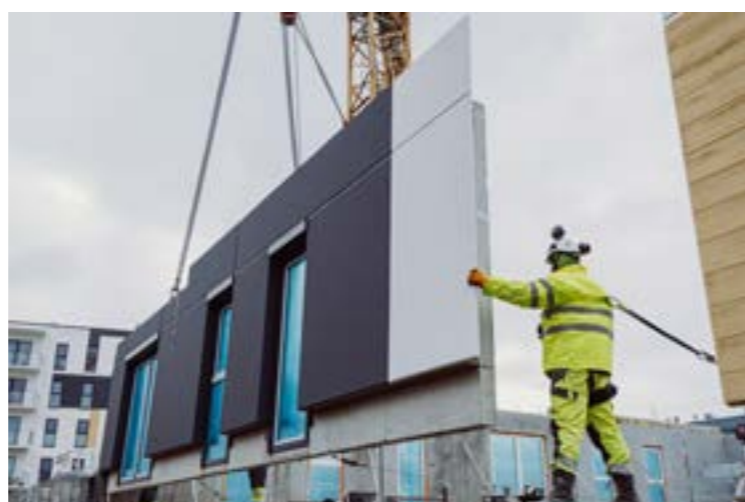
Montaż ścian na Osiedlu JA_SIELSKA, Poznań
