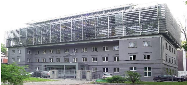
Siedziba WASKO S.A. Warszawa, ul. Czackiego
